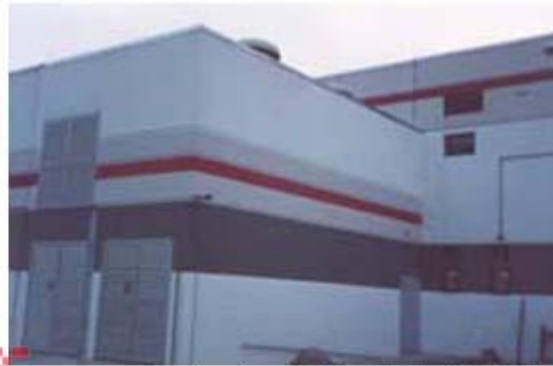
Construção da Subestação 1000 Kva
